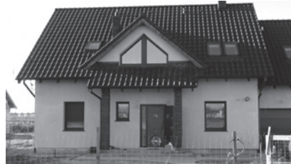
Fot. 2. Urządzenie zamontowane w drzwiach domu jednorodzinnej (fot. autorska)
