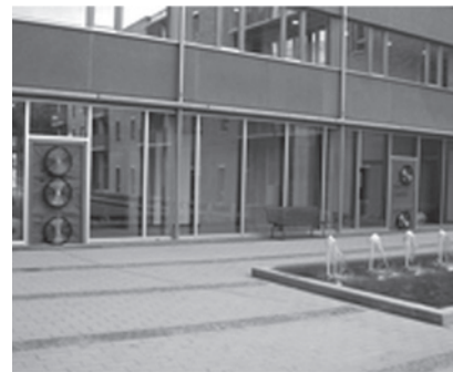
Fot. 3. Duży budynek (www.blowerdoor.de)
