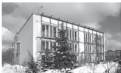
Fot. 1. Budynek pasywny w Darmstadt-Kranichstein
